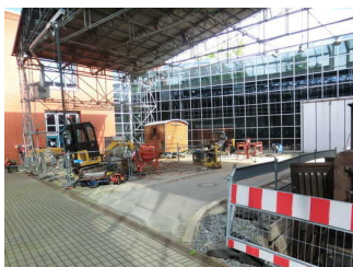
Exponate - mehr Sicherheit am Bau
